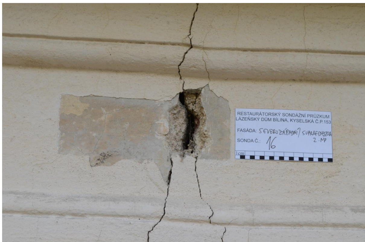
Obr. 21 S16 – sonda v místě hlubší trhliny propisující se do zdiva, původní vrstva žlutý okr, méně zřetelný vlivem zakalení a zašpinění, následuje mladší žlutý okr a současný bíle podložený nátěr
