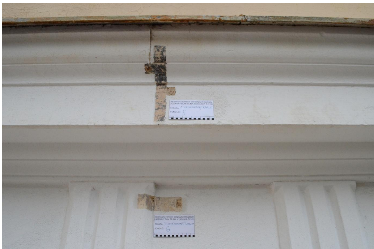
Obr. 7 S5, S6, vrstvy obdobné S1, plastický prvek modelován z identické omítkové hmoty použité v ploše fasády
