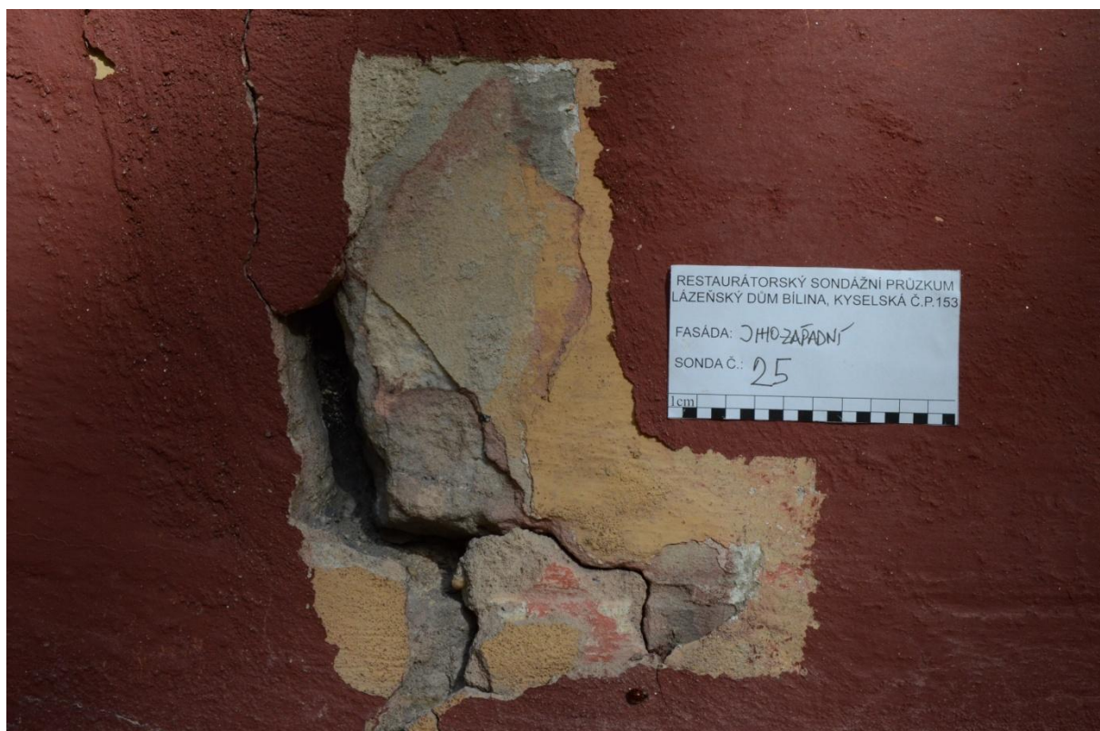
Obr. 31 S25 - sonda na pískovcovém soklu, v místě praskliny, kromě oprav je zde podobná posloupnost vrstev jako u S23
