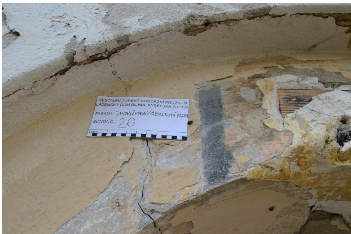
Obr. 32 S26 – sonda na stěně předsunutého parteru, nejstarší barevnost prokazatelně šedá , následovaná žlutými okry, světle šedou a opět okrovými nátěry
