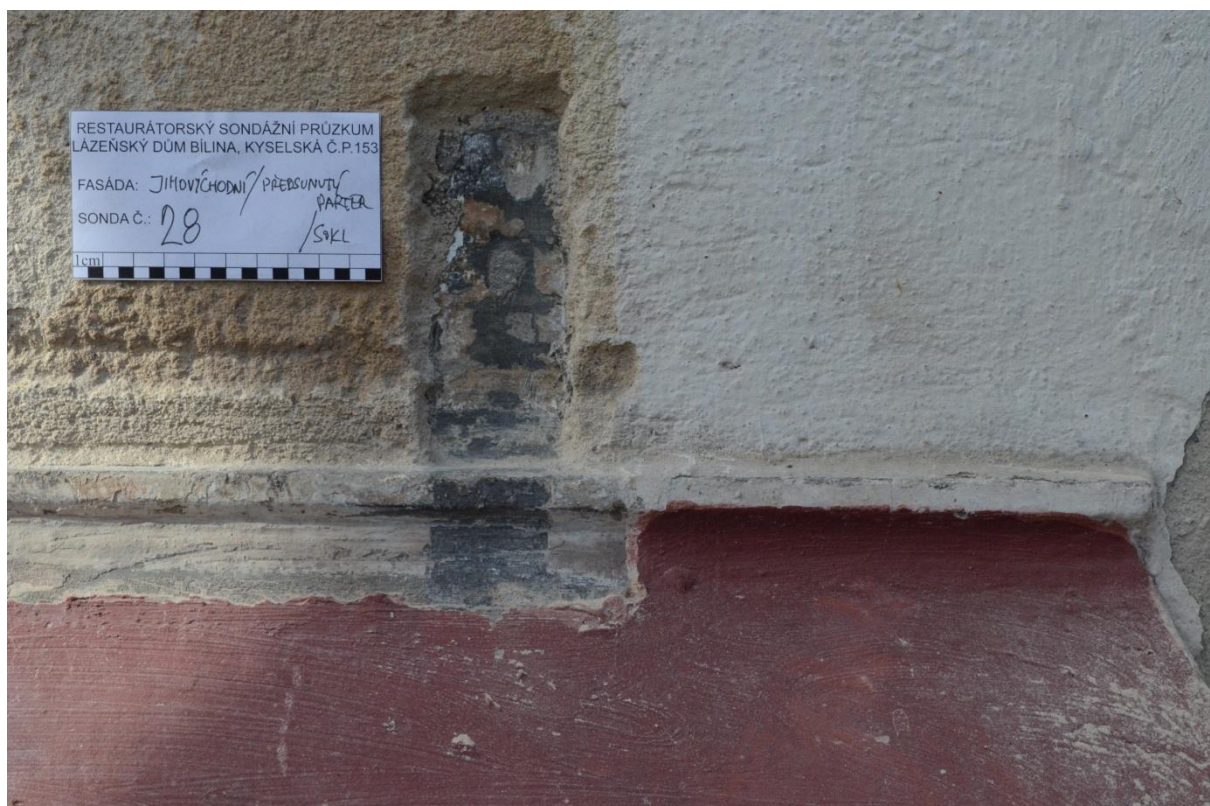
Obr. 34 S28 velmi tvrdé, s hydraulickou přísadou? (hydraulické vápno?, rané použití cementu?), původní barevnost prokazatelně šedá následovaná fragmenty žlutě až červeně okrových
