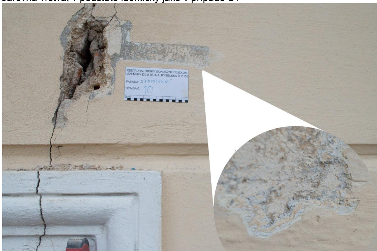
Obr. 12 Předchozí sonda s přiblížením seříznutých vrstev
