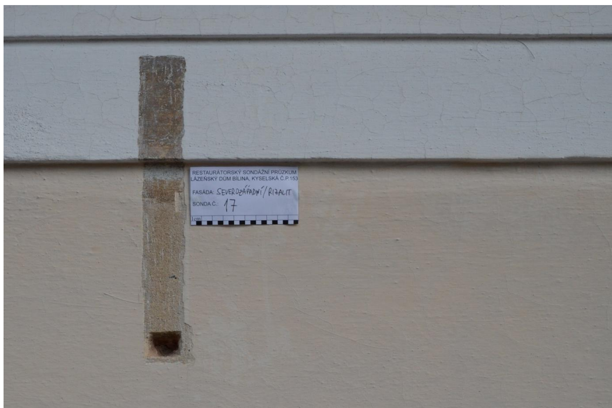
Obr. 22 S17 – ačkoliv není vrstva dobře zřetelná je původní barevná vrstva žlutý okr následovaný šedou (zašpinění?), barevné odlišení nedoloženo
