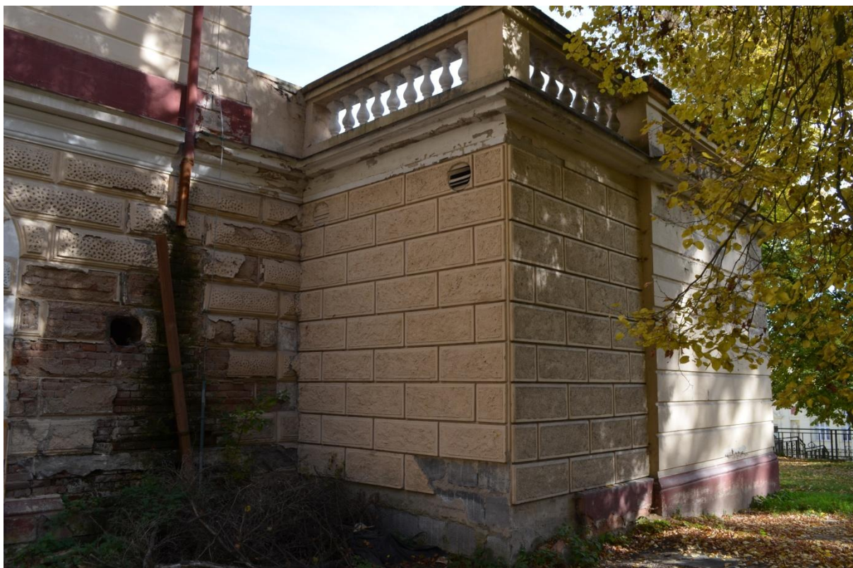
Obr. 41 Dostavba terasy z pórobetonových tvárníc, 80. léta?, nekorespondující bosáž, členění by mělo navazovat a kopírovat členění na stěně domu
