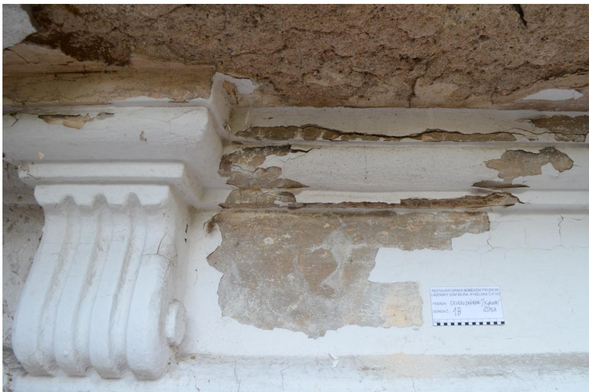
Obr. 23 S18 – nálezová situace, v této partii jsou omítky korunní římsy značně poškozeny zatékáním, barevné vrstvy zvětralé, nesouvislé, původní pravděpodobně žlutý okr, barevné odlišení nedoloženo
