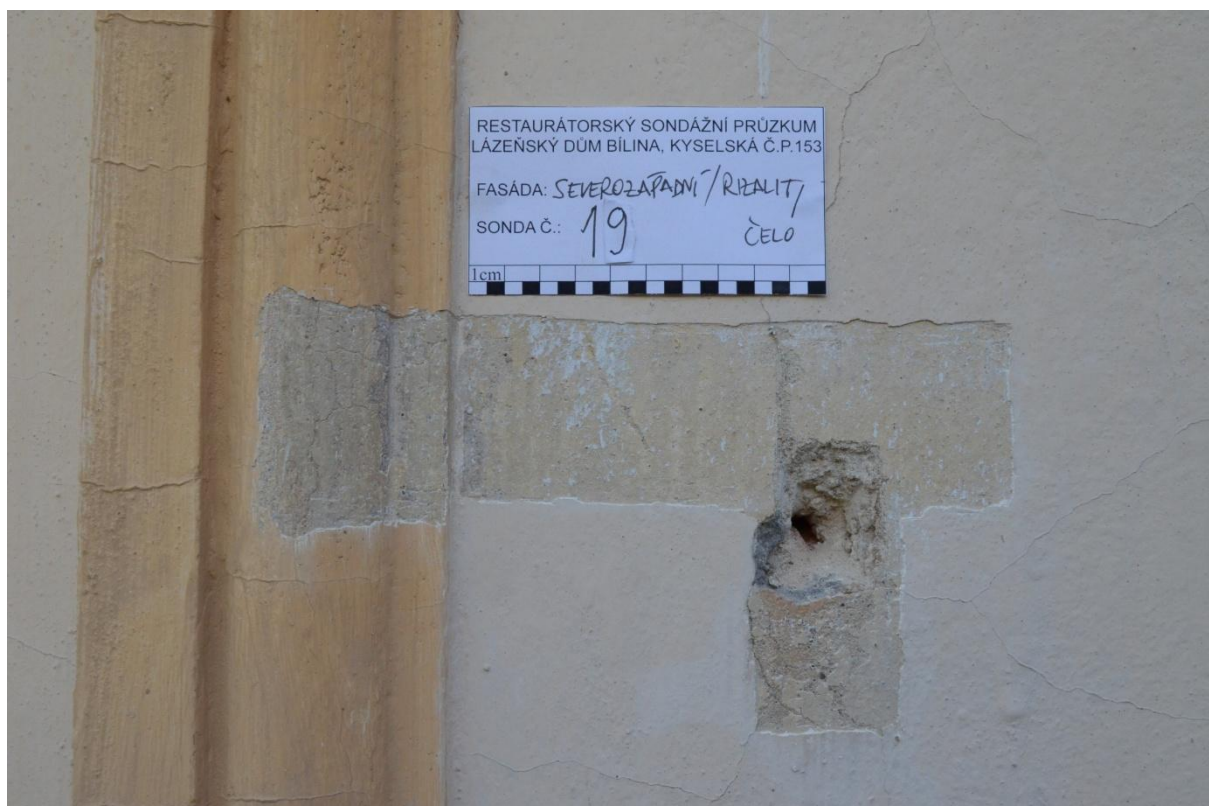
Obr. 24 S19 – starší vrstvy dochovány nesouvisle ve fragmentech, původní pravděpodobně žlutý okr, odlišení nedoloženo
