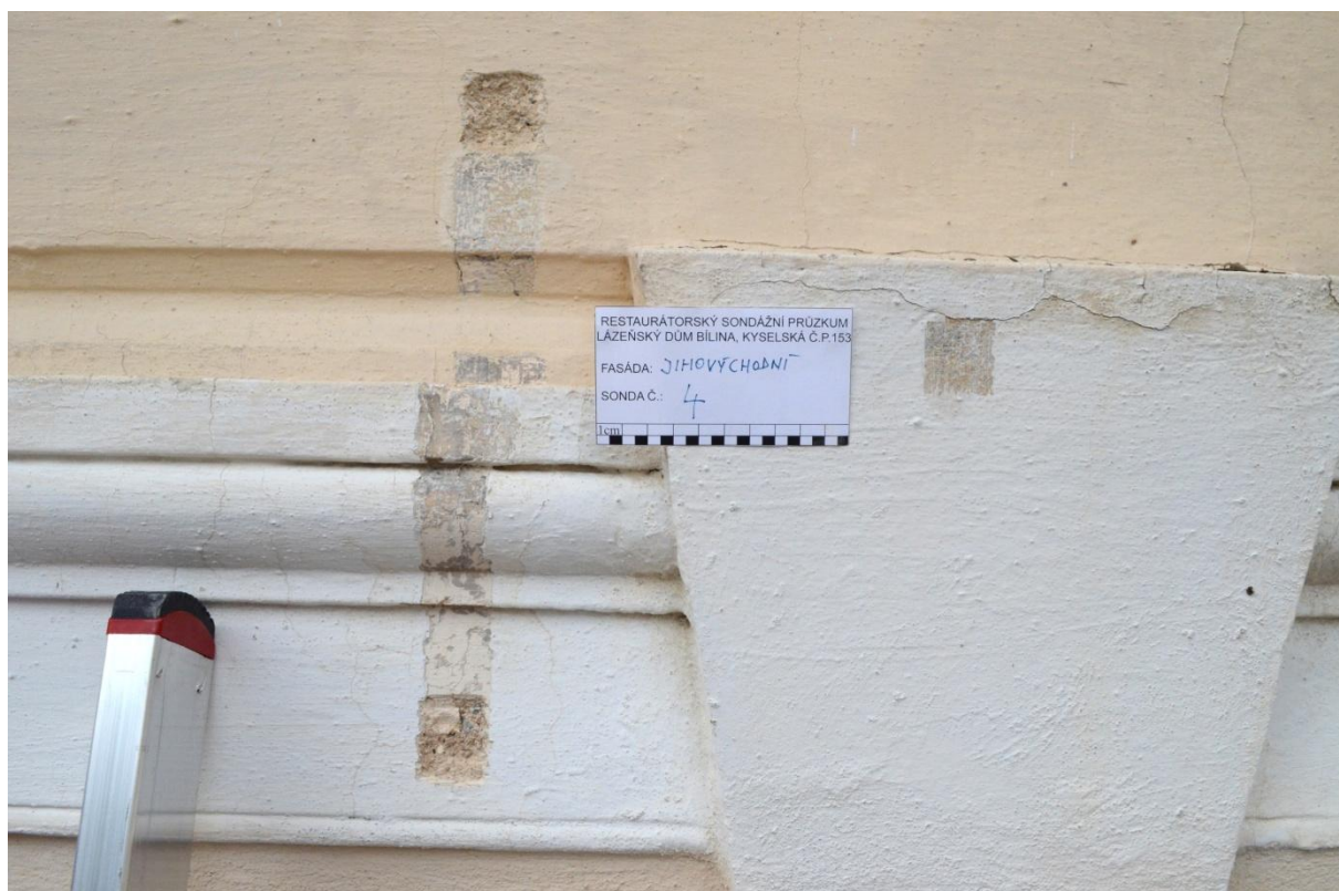
Obr. 5 S4, posloupnost vrstev obdobná jako u S1, omítka v ploše a štukového prvku je identická
