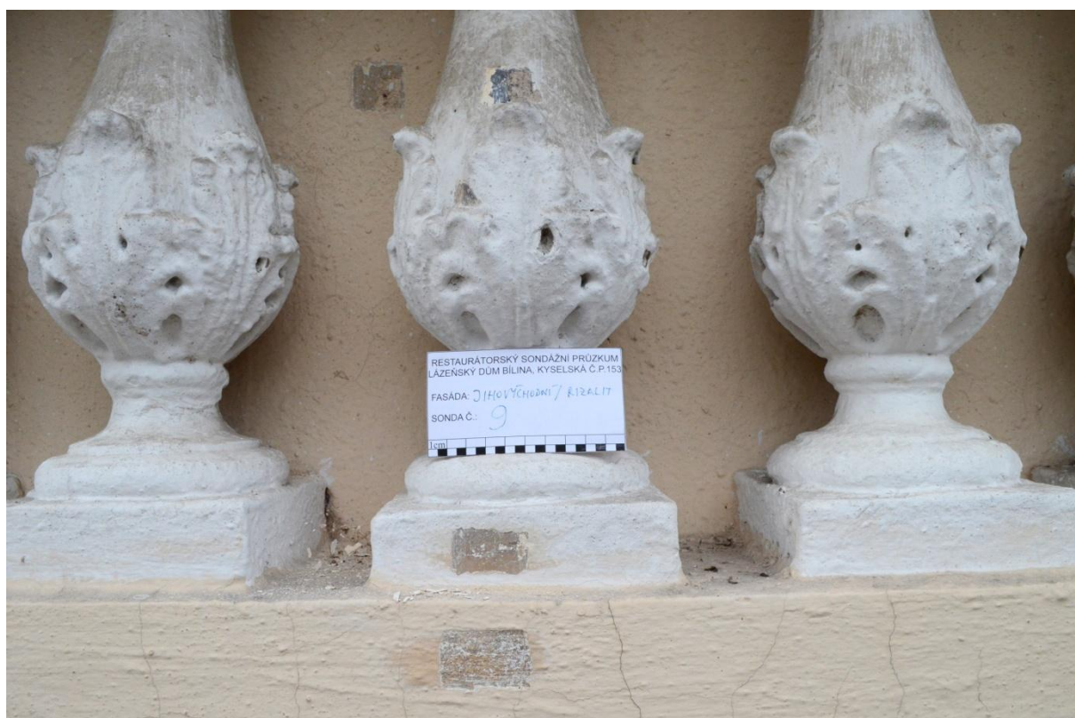
Obr. 9 S9, v nejstarší barevné vrstvě dokládán opět žlutý okr, na kuželce doložena tmavě šedá, toto odlišení vzniklo pravděpodobně až s určitým odstupem ve druhé nátěrové fázi (viz. S12)
