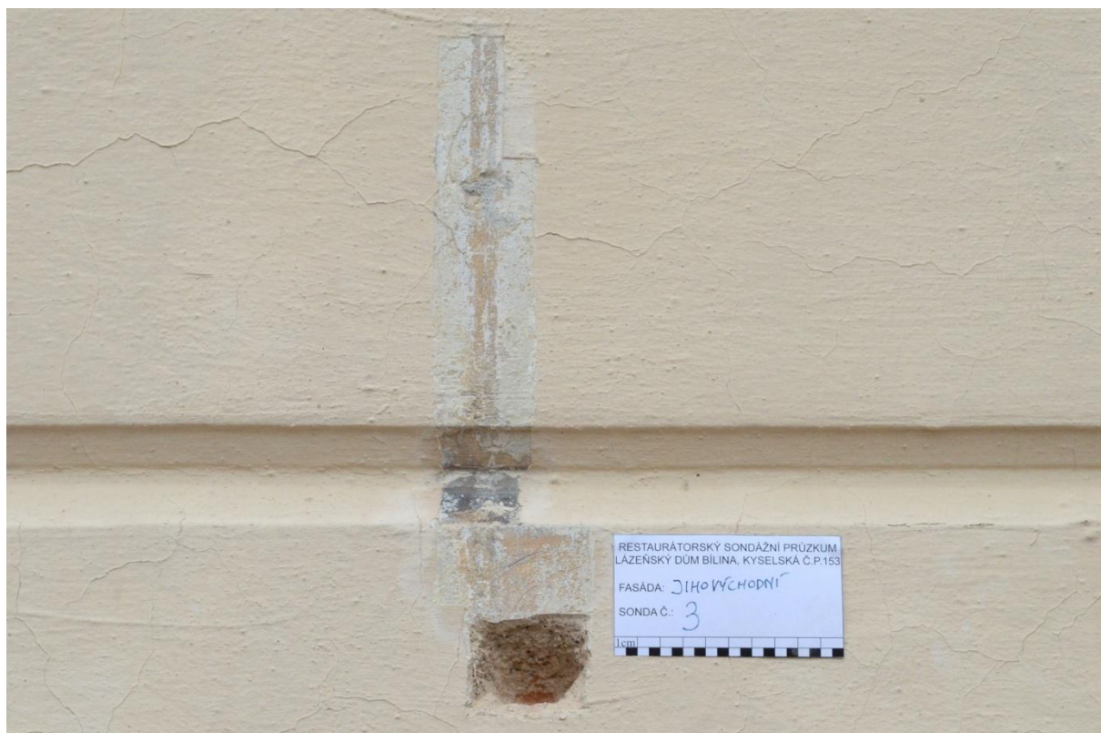
Obr.4 S3, posloupnost vrstev obdobná jako u S1
