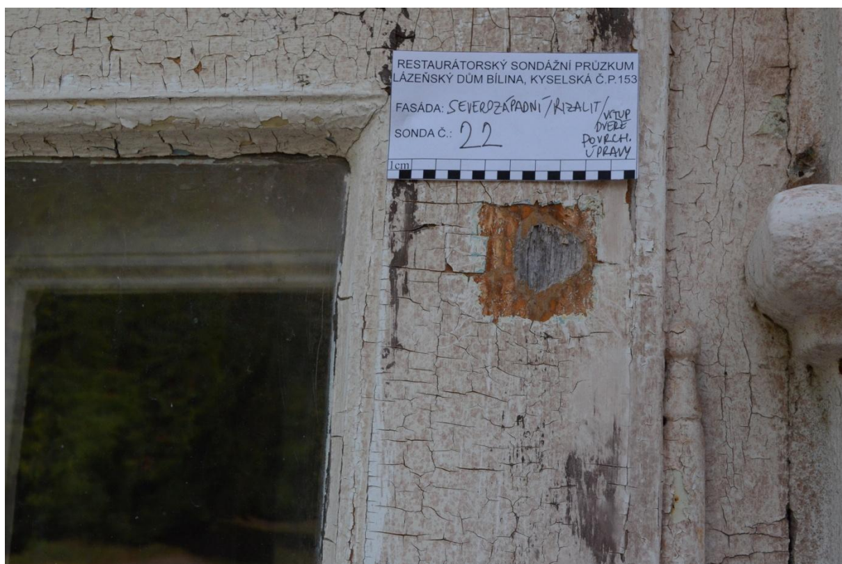
Obr. 27 S22 - sonda na barevnost původních dveří, původní barevná vrstva hnědá, velmi podobná stratigrafie jako v případě okna (S13)
