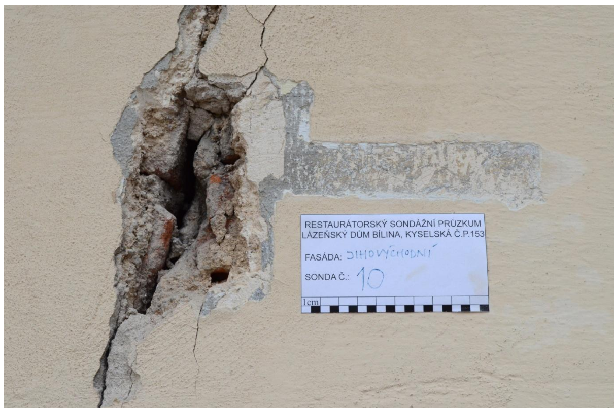
Obr. 11 S10, sonda v místě větší trhliny, která se propisuje od povrchu až do hmoty zdiva, patrné vrstvy omítkových oprav, vrstvy nátěrů viz. makro, rámcově po dvou žlutě okrových nátěrech (z nichž druhý je bíle podložen) následuje žlutá a lomená barevná vrstva, v podstatě identicky jako v případě S1
