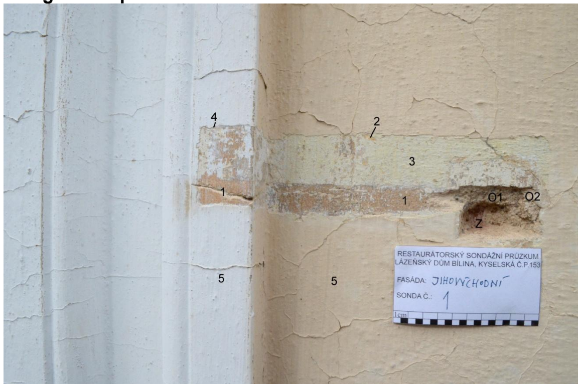
Obr. 1 Sonda č. 1 S1 – cihlové zdivo, omítka tvrdá, pravděpodobně čistě vápenná, jádro ca. 3 cm silné, štuk jemnější, světlejší, v těchto místech se sítí trhlin, nejstarší barevná vrstva žlutý okr bez odlišení šambrány okna , pravděpodobně bez obvyklého bílého podkladového vápenného líčka, následuje druhý bíle podložený žlutý okr, bíle podložená žlutá, lomený hnědookrový tón a současný žlutý okr s bíle odlišenou šambránou okna
