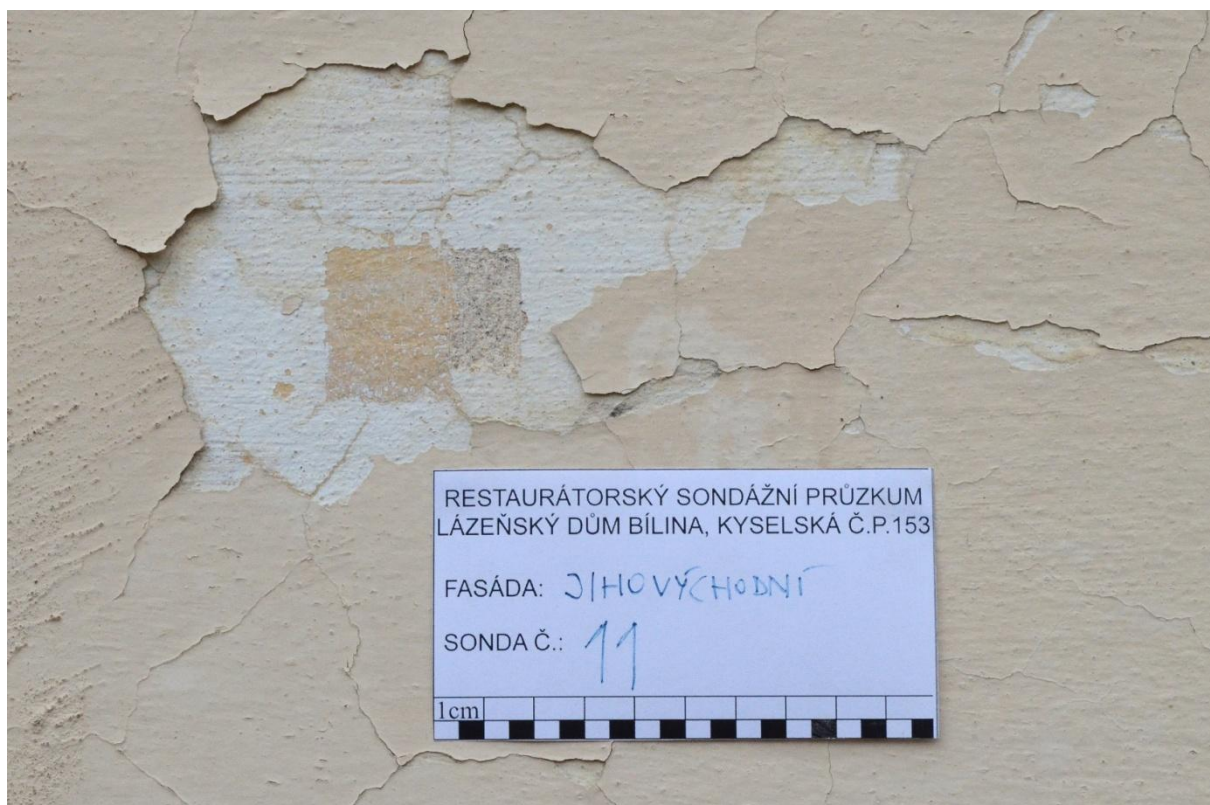
Obr. 13 S11 – pod současným olupujícím se nátěrem se nachází méně vrstev (odstraněny?), jen bílá a pod ní pouze dvě vrstvy žlutého oku (původní tonalita?)
