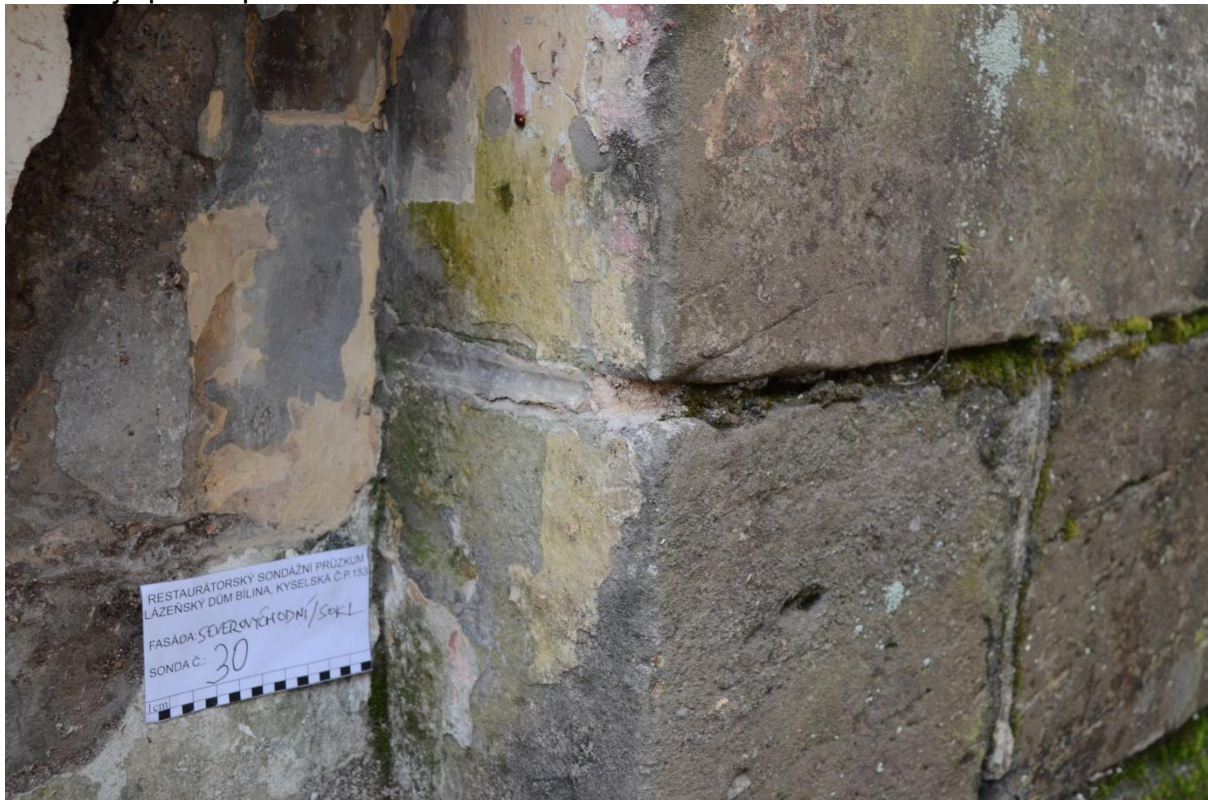
Obr. 36 S30 – sonda na soklu poblíž nároží jihovýchodní a severovýchodní fasády, nejstarší barevná vrstva šedá , následovaná posloupností okrů, viditelné původní řešení spárování soklu, (do tmelu spáry vprostřed vytlačený oblý žlábek)
