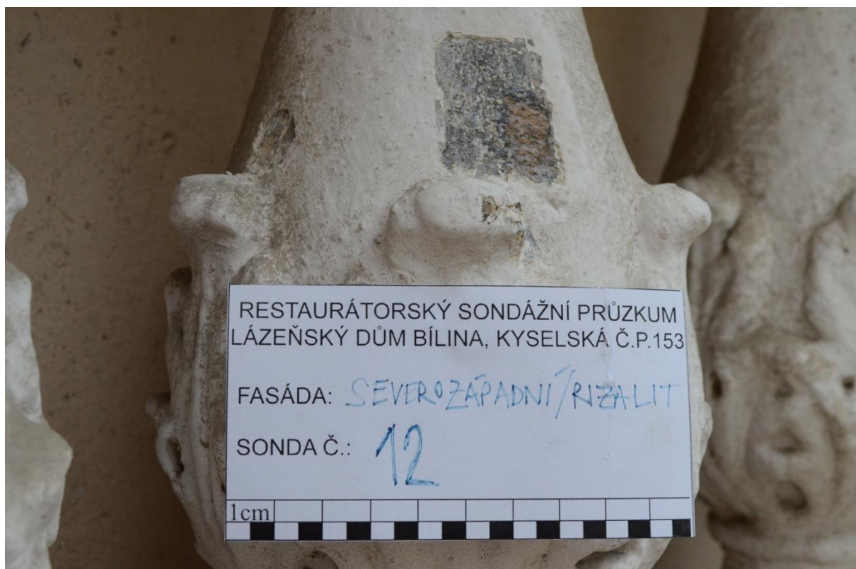
Obr. 15 S12, na kuželce pod oknem boční fasády příčného křídla, zdá se, že nejstarší vrstvou je žlutý okr (špatně odkryvatelný) následovaný souvrstvím šedých nátěrů, mezi mladšími vrstvami se pod současnou bílou nachází světle žlutě okrová a bílá
