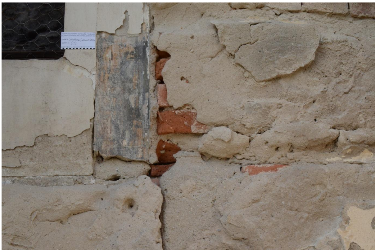
Obr. 35 S29 - sonda na stěně předsunutého parteru, nejstarší nátěr je šedý následuje posloupnost okrů
