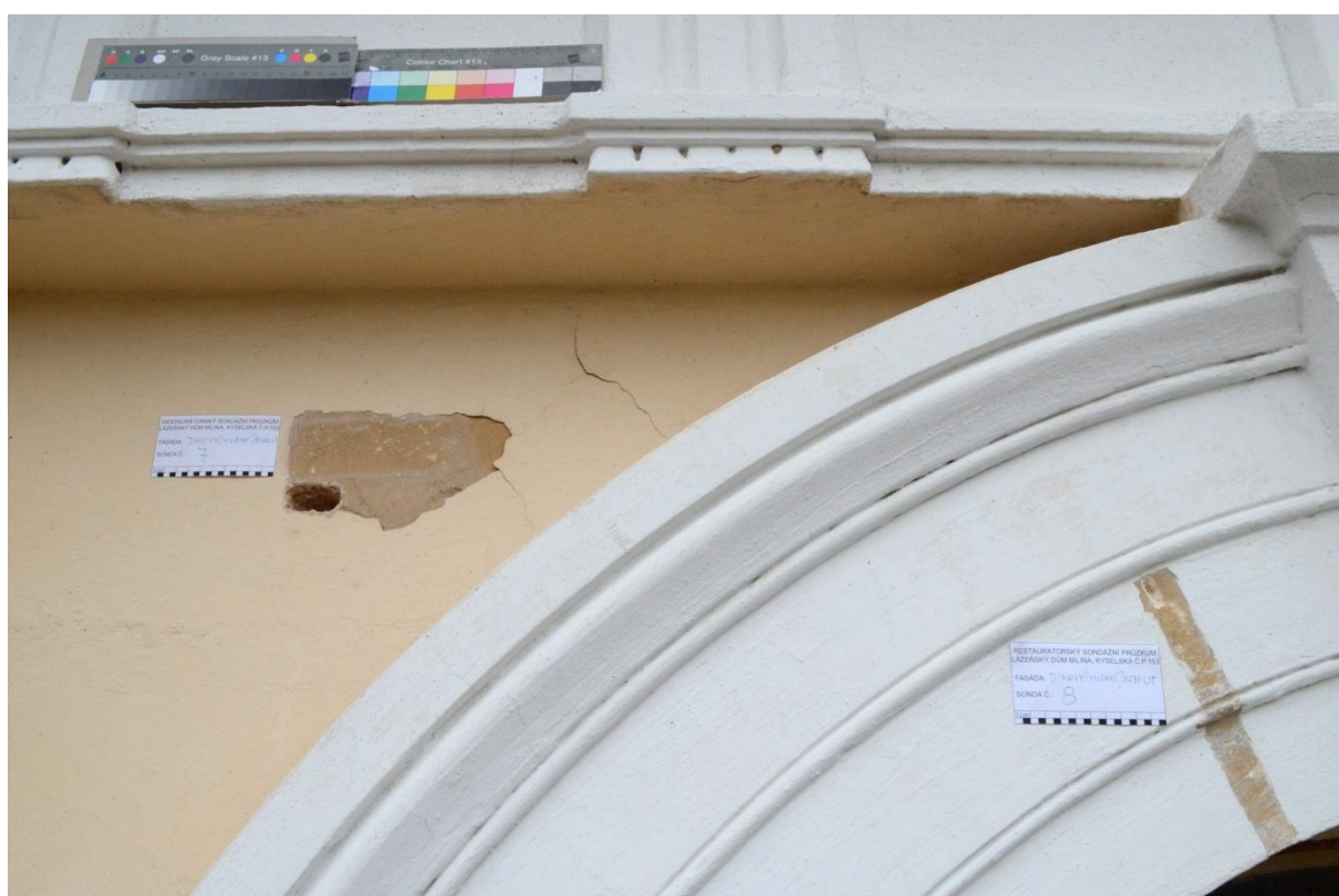
Obr. 8 S7, S8 – původní omítka s mírně zrnitým povrchem a sítí prasklin, původní barevná vrstva žlutý okr, mladší vrstvy nedochovány, následuje současná nátěrová vrstva, na plastické šambráně vstupu identický žlutý okr jako v navazující ploše
