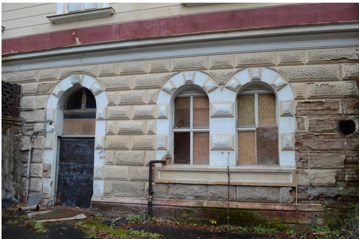
Obr. 40 Úsek parteru jihozápadní fasády je jediným úsekem s dochovaným původním plastickým členěním (bosáž, částečná rustika kolem oken a dveří, sokl, římsa), toto členění bylo původně i na čelní stěně parteru
