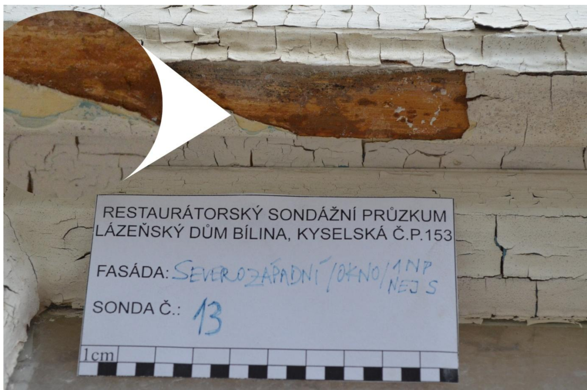
Obr. 17 S13 – jedno z mála oken s původními vnějšími křídly, sonda na barevnost okna, původní nátěr byl hnědý, následuje silná vrstva bílé, lomeně žlutá, modrozelená, lomeně bílá a bílá
