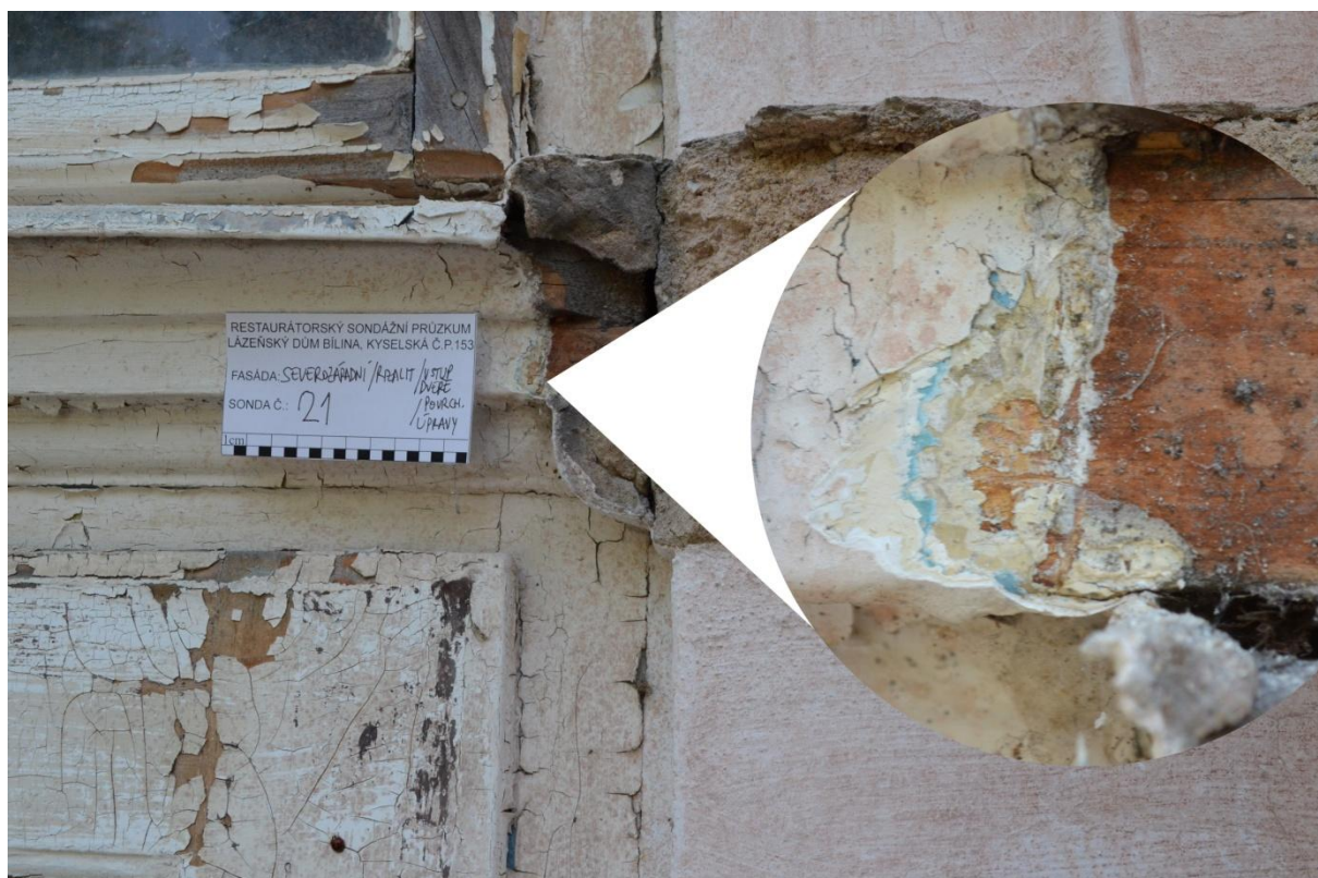
Obr. 26 S21 – sonda na barevnost původních dveří, původní barevná vrstva hnědá, velmi podobná stratigrafie jako v případě okna (S13)
