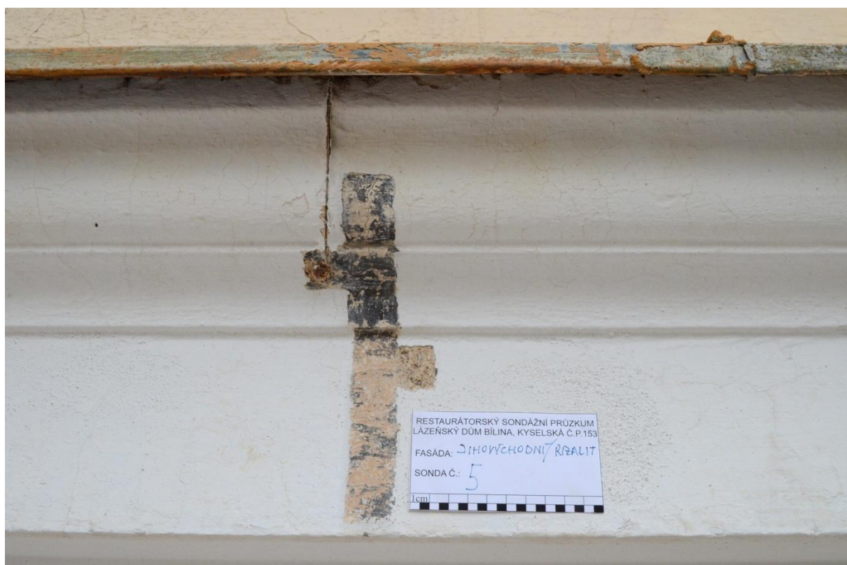
Obr. 6 S5 - posloupnost vrstev obdobná jako u S1, kromě tmavě šedé, která následuje po původním okru, obdobná šedá ve stejné pozici doložena u S9 na kuželkách, drátek je přichycením opravy oplechování k římsě
