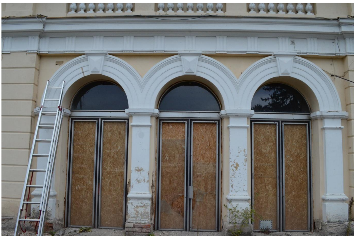
Obr. 46 Novodobé dveře, spolu s dalšími dvěma kovovými (80. leta?) v jiných fasádách navrhujeme vyměnit za repliky původních dřevěných (viz. obr. 50)
