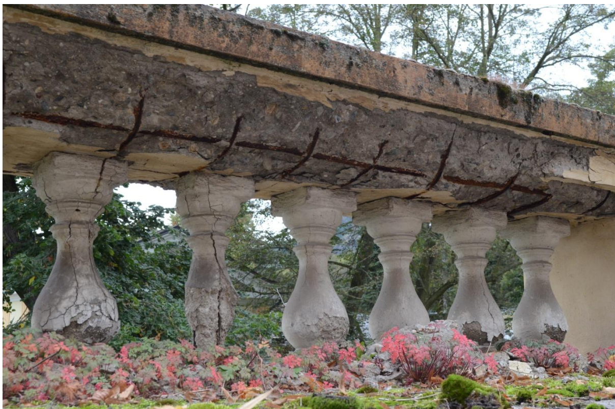
Obr. 39 Balustráda terasy rekonstruovaná v 80. letech je v rozkladu
