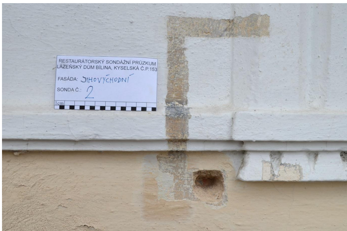
Obr. 3 S2, cihlové zdivo, vrstvy obdobné S1, barevné odlišení nedoloženo, původní povrch poškozen, místy šedá sulfatizace?, plastické prvky modelovány in situ
