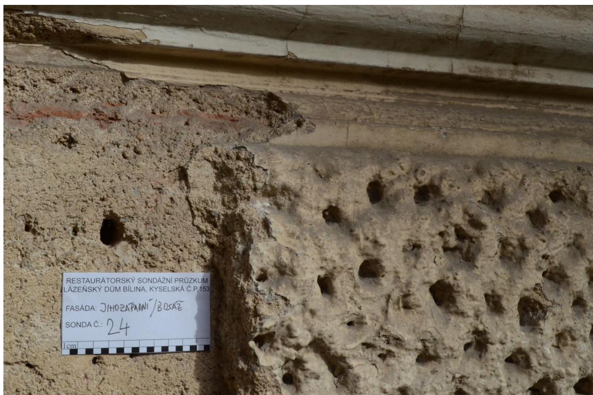
Obr. 30 S24 – sonda dokládá výstavbu bosáže jihozápadní fasády
