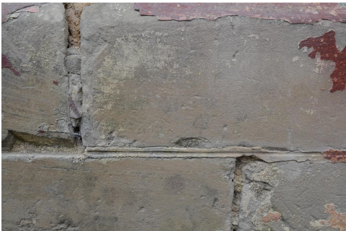
Obr. 38 Původní forma spárování soklu
