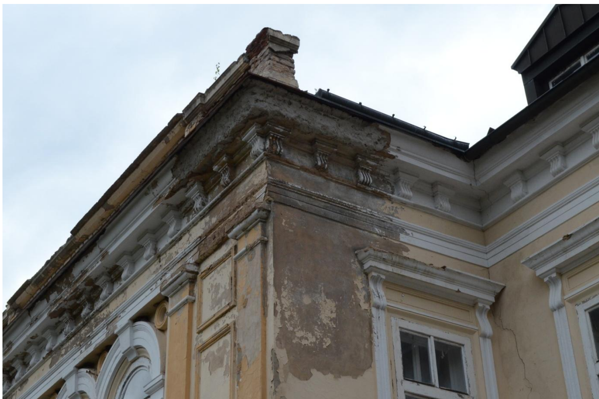
Obr. 47 Dokumentace poškození atiky rizalitu, korunní římsy a navazujícího úseku
