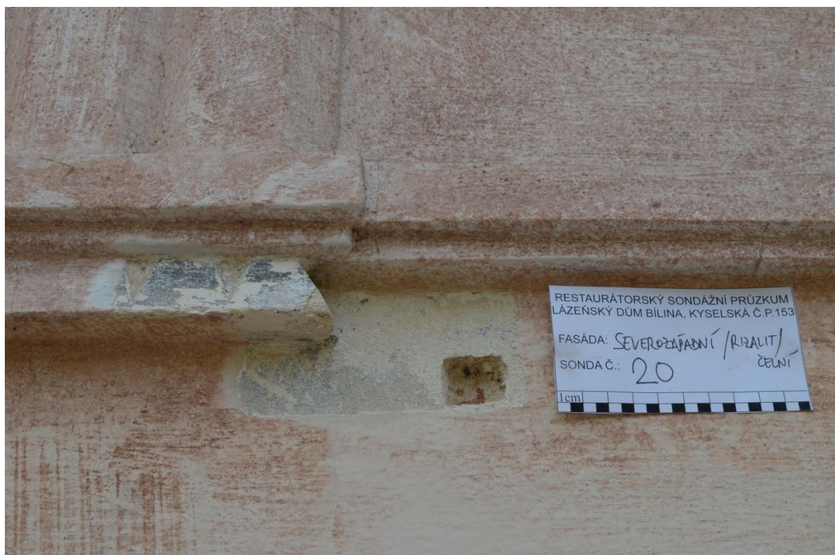
Obr. 25 S20 - starší vrstvy dochovány nesouvisle ve fragmentech, původní pravděpodobně žlutý okr, mezi mladšími vrstvami šedá, plastické členění (kapky pod triglyfem) nemodelovány tak zřetelně, jako na fasádě terasy (oprava?)
